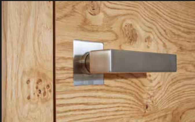
Türdetail stumpf einschlagend | Zarge Eiche astig | kein sichtbares Schließblech (Magnetfallenschluss)
